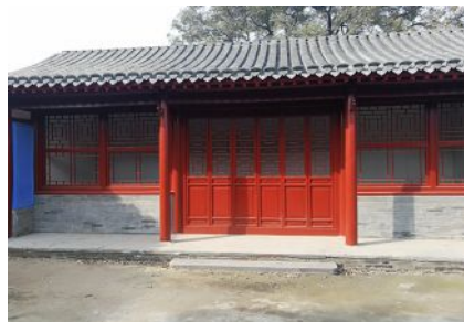
公所院西路一进院东厢房改造后
