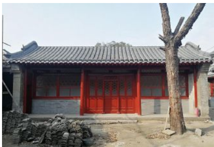
东路一进院西厢房改造后
