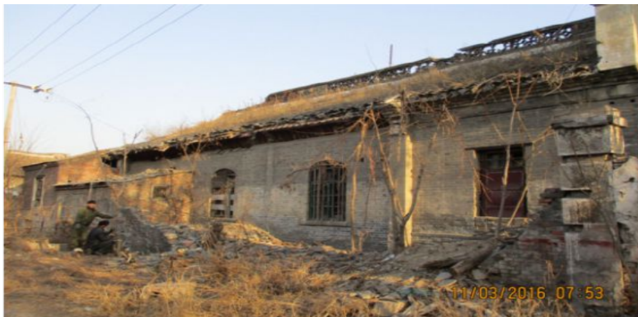
昭忠祠大门倒座南立面改造前
